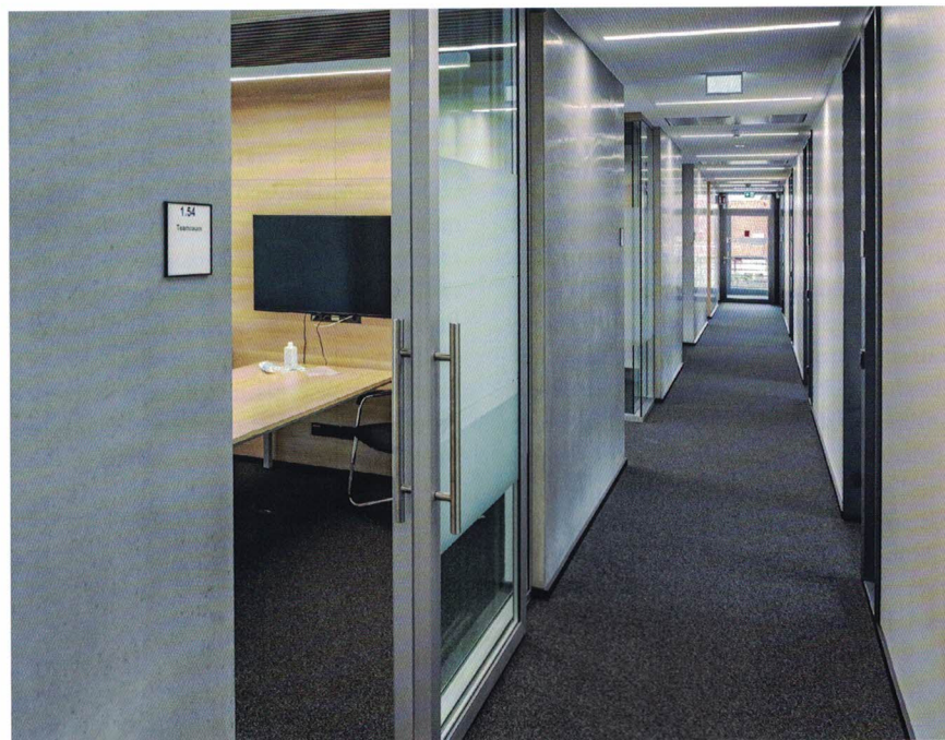
Im Prüfversuch hat die neue Türkonstruktion einen Schalldämmwert von 40 dB R_{w,P} erreicht (links). Bei der Konstruktion wurde 16 mm VSG-Si-Schallschutzglas mit einem ausgeklügelten Dichtungssystem kombiniert (rechts).
