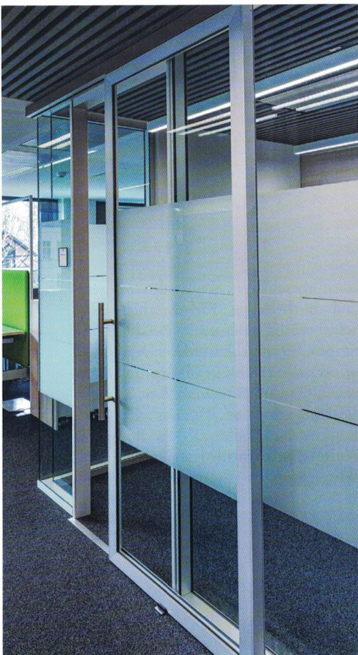
Im Prüfversuch hat die neue Türkonstruktion einen Schalldämmwert von 40 dB R_{w,P} erreicht (links). Bei der Konstruktion wurde 16 mm VSG-Si-Schallschutzglas mit einem ausgeklügelten Dichtungssystem kombiniert (rechts).
