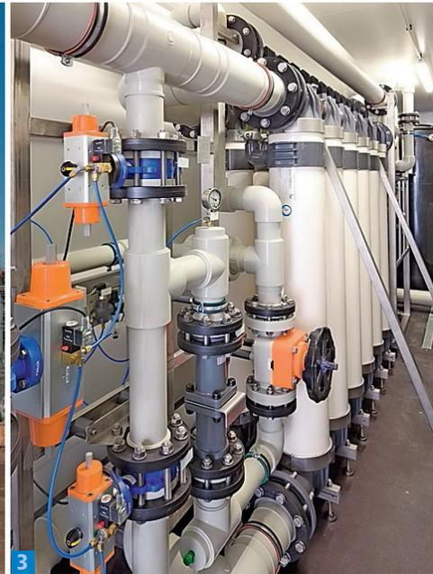
**2** Innerhalb von Großanlagen können schon kleinste Mengen an gelösten Salzen schwere Schäden an Bauteilen verursachen. Der Einsatz von unaufbereitetem Wasser birgt damit in Fernwärme- oder Fernkälteanlagen ein großes Gefahrenpotential. Eine Lösung bietet Orben mit mobilen Wasseraufbereitungsanlagen, die VE-Wasser in Kesselspeisewasserqualität erzeugen.
